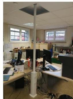
Mise en conformité électrique des bureaux administratifs du service formation/sport pour limiter l'utilisation des blocs multiprises (demande CHSCT)
