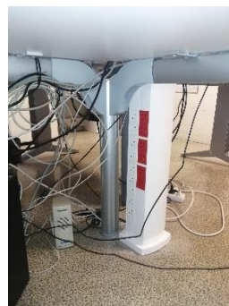
Mise en conformité électrique des bureaux administratifs du service formation/sport pour limiter l'utilisation des blocs multiprises (demande CHSCT)
