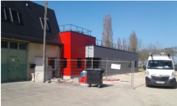
Mise en service de l'extension du CS Gallardon (14/11/17)
