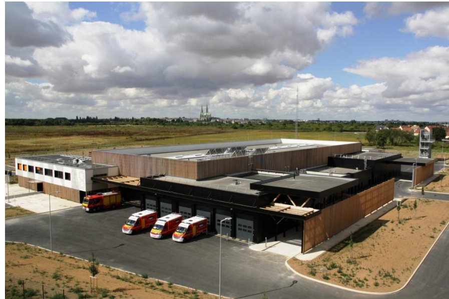
Mise en service du CSP Chartres (23 octobre 2015)
