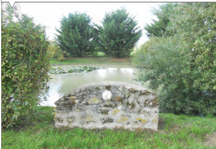
Colonne fixe d'aspiration alimentée par un point d'eau naturel
