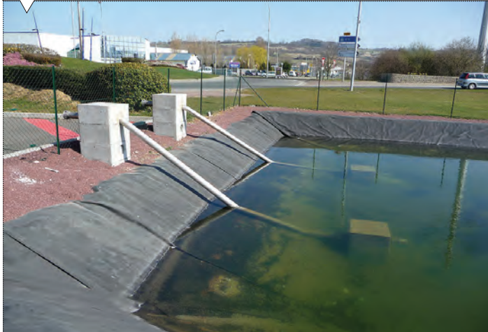
Colonnes fixes d'aspiration alimentées par une réserve ouverte
