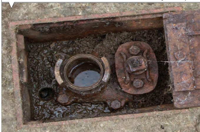
Bouche d'incendie de 100 mm à demi-raccord symétrique
