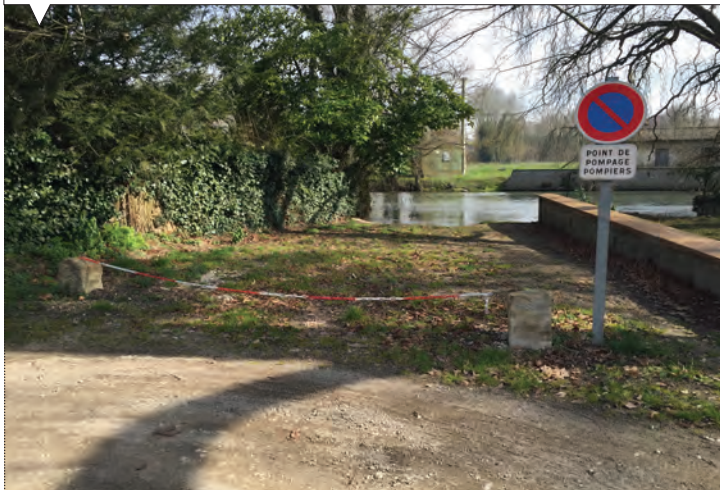
Plate-forme d'aspiration près d'un cours d'eau
