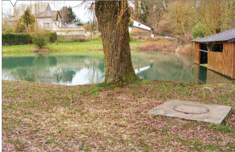
Point d'aspiration déporté sur une mare (sans dispositif fixe d'aspiration)
