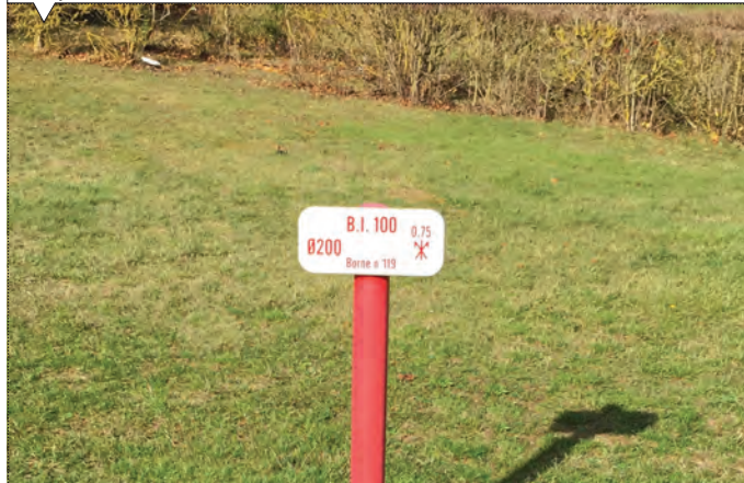
Plaque indicatrice d'une bouche d'incendie
