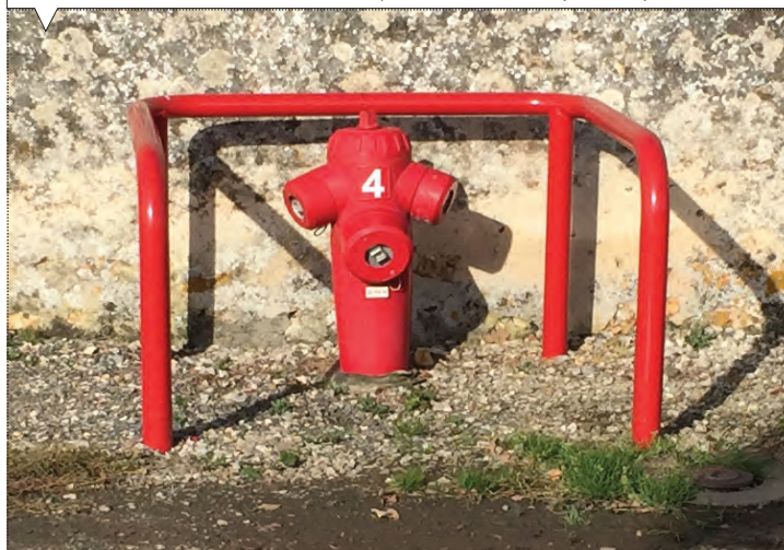
Poteau d'incendie « DN 100 » (raccord 1x100/2x65)
